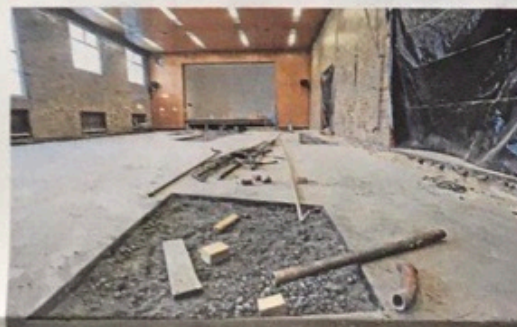
Der alte Hallenboden stammt aus dem Jahr 1953 und war schon zwei Mal abgeschliffen worden – da war nichts mehr zu machen.
