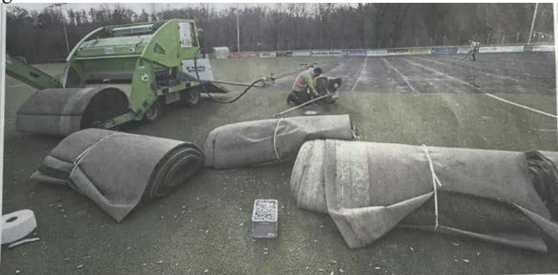
Kunstrasen, verschürt und gerüttelt: Die Sanierung des Fußballplatzes in der Balkler Aue ist angelaufen. Foto: Ralf Krieger
